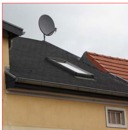
Fremdbeispiel: die Parabolantenne überragt das Dach zu stark, deren Farbigkeit fällt leider auf
