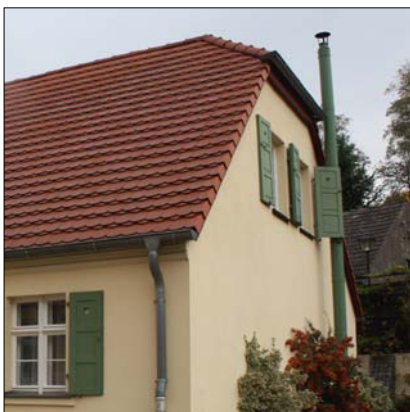
Neue Promenade 17: Krüppelwalm, Eindeckung mit Biber-schwanz in Kronendeckung
