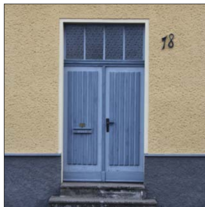
Hauptstraße 78: in die Tür integrierter, farbgleicher Briefschlitz
