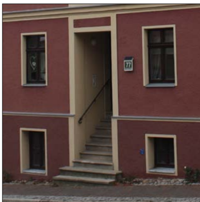
Hauptstraße 77: die Zugangstreppe führt weit hinter die Gebäudefassade - Lösung der Gründerzeit
