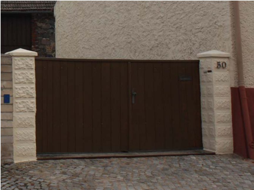
Königstraße 50: Holztor mit senkrechter Verbretterung, gerader oberer Abschluss, brauner Farbton, seitliche Aufhängung an Pfeilern (Bossensteine sind allerdings untypisch), Briefschlitz ordnet sich dezent unter
