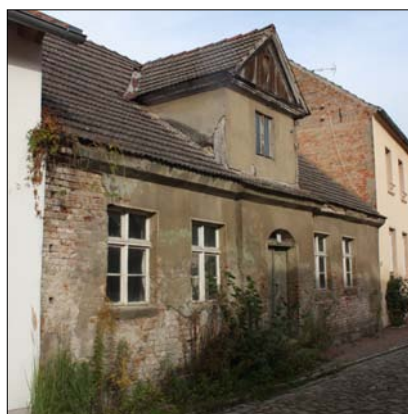
Wallstraße 15: großes Dachhäuschen (Giebelgaube) über durchgehender Traufe
