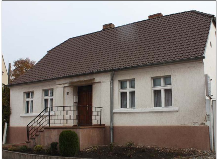
Königstraße 51: eingeschossiges Ackerbürgerhaus mit symmetrischer Fassade, Vorsprung um den mittigen Eingang (hier mit seitlichen Lisenen und Sims, i.d.R. nur Fassadenvorsprung); hier mit hohem Sockel
