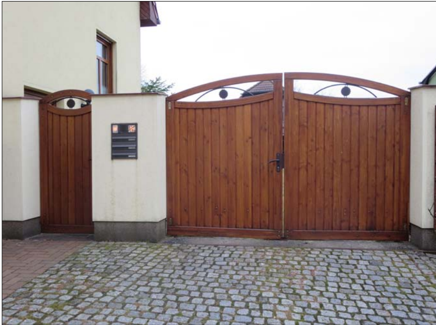
Hauptstraße 13: Im Mauerabschnitt (Pfeiler) integrierte Klingel- und Briefkastenanlage
