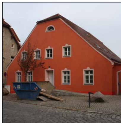
Die Sanierung der Königstraße 54 ist fast abgeschlossen - die kräftige Farbe ein Blickfang.
