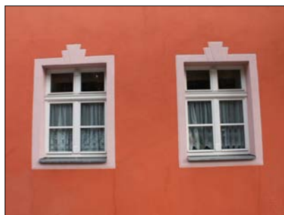
Königstraße 54: Fensterkreuz mit zusätzlicher Sprosse im unteren Drittel
