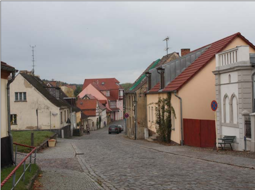
Die Königstraße führt in Höhe der Neuen Promenade hinab Richtung Stadtmitte. Die ein- und zweigeschossigen Häuser begleiten die Straße. Sie wurden ohne seitlichen Grenzabstand und unmittelbar an der straßenseitigen Grundstücksgrenze errichtet.
