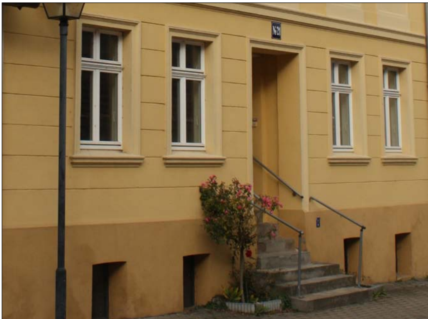
Neue Promenade 21: Der Sockel wurde im gleichen Fassadengrundton dunkler, Gewände und Dekor im gleichen Fassadengrundton heller abgesetzt. Das Gebäude wirkt so als Einheit.
