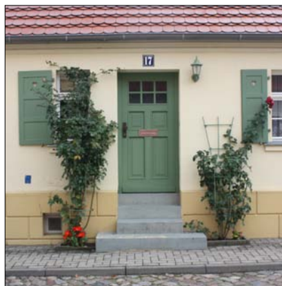
Neue Promenade 17: Fassadenbegrünung mit Kletterrosen betonen den Hauseingang
