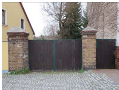
Hauptstr. 80: Holztor und Tür mit senkrechter Verbretterung und geradem oberem Abschluss, Toraufhängung an massiven Pfeilern
