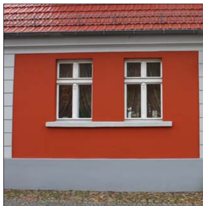
Königstraße 1: mit einer gemeinsamen Sohlbank zusammengefasstes Fensterpaar
