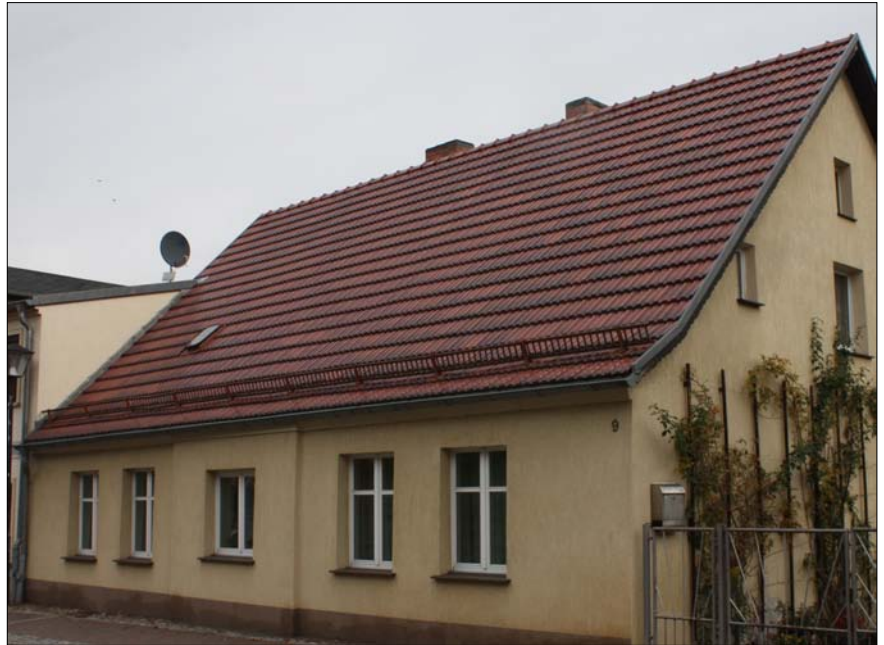
Wriezener Straße 9: Das ruhige, geneigte Satteldach ohne Gauben mit roter Eindeckung aus Ziegeln gehört zur Ortstypik im Stadtkern Buckows.
