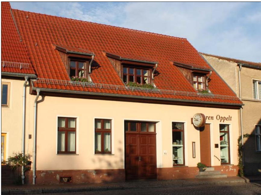
Hauptstraße 6: Schleppgauben ordnen sich unter durch ihre gegenüber den Fassadenfenstern verringerte Größe, Abstand vom Ortgang, Bezug zu den Fassadenöffnungen, Aufnahme vorhandener Farbigkeit
