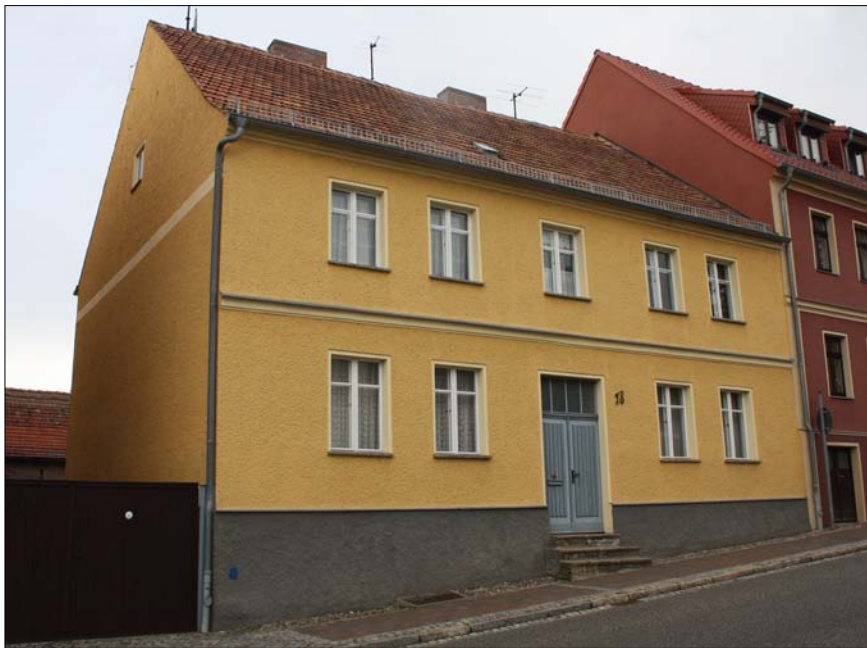
Hauptstraße 78: zweigeschossiges Bürgerhaus mit schlichter, symmetrischer Fassade, des Gurtgesims zwischen Erd- und Obergeschoss und der Sockel gliedern das Gebäude
