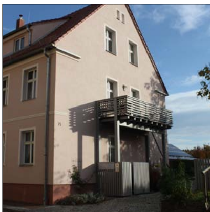
Hauptstraße 74: Balkon seitlich am Giebel, zurückgesetzt von der Straßenfassade, farblich stimmig
