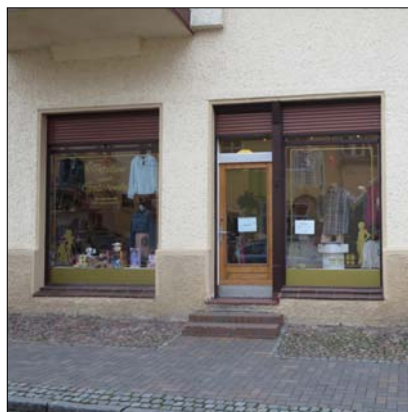
Hauptstraße 4: historische Gliederung der Schaufenster in stehende Formate; Tür passt leider nicht
