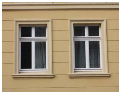
Neue Promenade 21: Fensterkreuz, Rahmung mit Gewänden und Sohlbank
