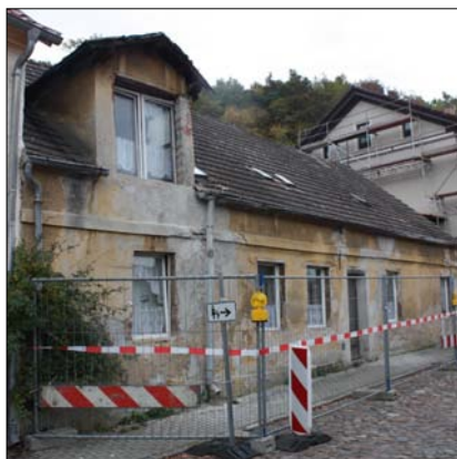
Neue Promenade 15 mit Drempel, das Gurtband gliedert die Fassade in Höhe der Geschossdecke
