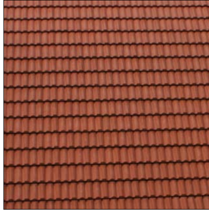
Doppelmuldenfalzziegel mit Mittelrippe und seitlichen Ziegelmulden
