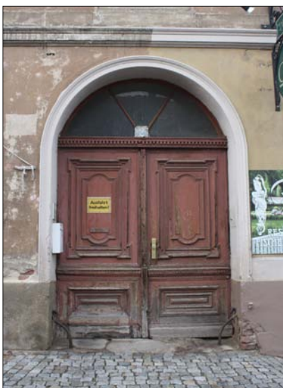
Hauptstraße 2: zweiflügeliges Tor mit Oberlicht im Rundbogen
