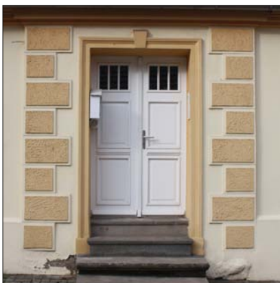
Neue Promenade 20: Briefkasten und Türklingel sind kaum sichtbar in der Türlaibung angeordnet
