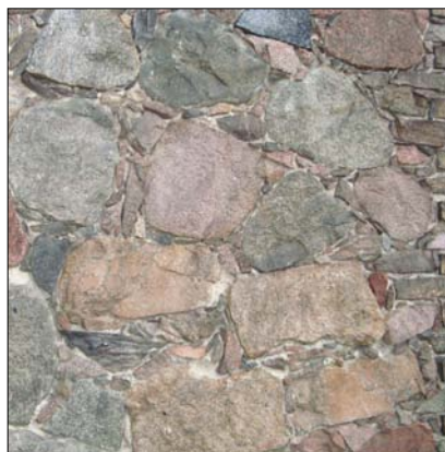
Mauerwerk aus geschlagenen Feldsteinen
