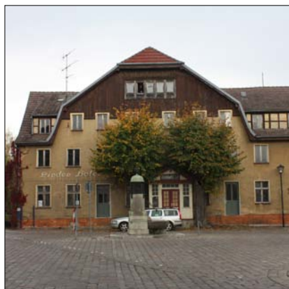
Das markante Gebäude Nr. 5 begrenzt den Markt - hier beginnen erste Sanierungsmaßnahmen.
