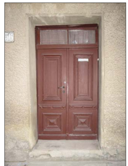
Königstraße 56: Hauseingangstür mit Oberlicht über den Türflügeln
