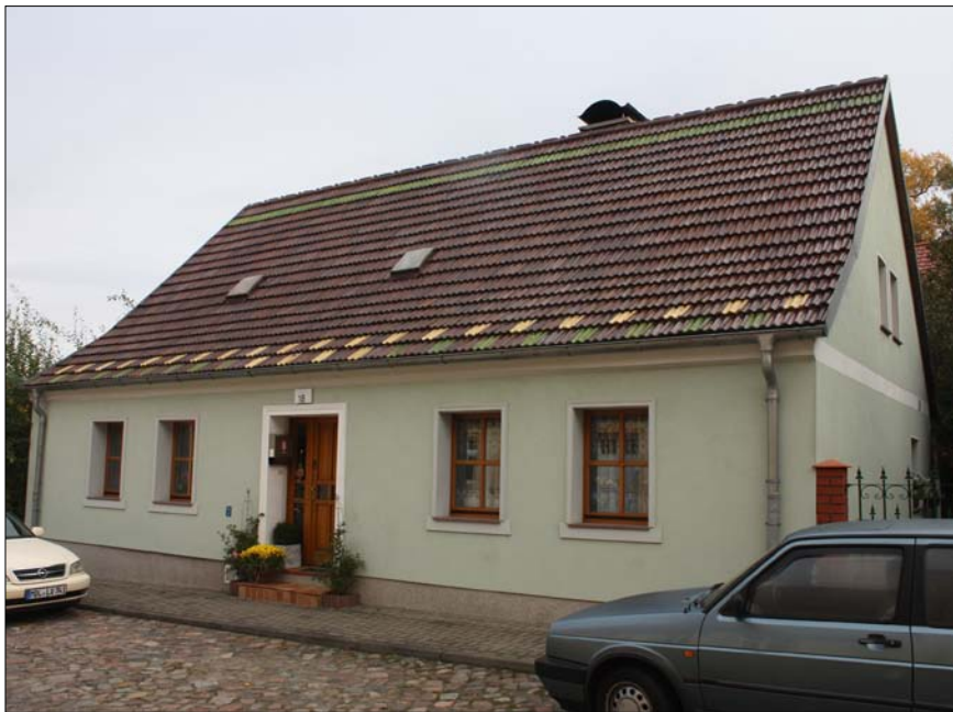
Neue Promenade 18: eingeschossiges (Acker-) Bürgerhaus auf langgestreckter rechteckiger Grundfläche
