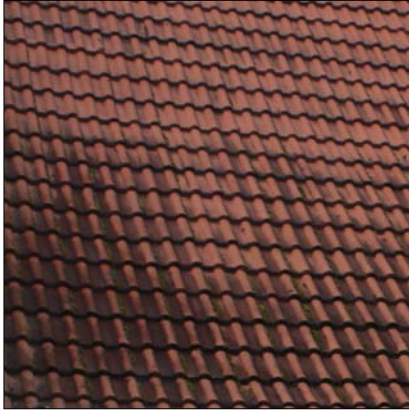
Hohlpfanne oder Hohlfalzziegel bilden im Querschnitt die Form eines liegenden S, einer Welle
