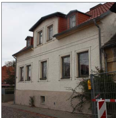
Neue Promenade 16: Gurtband zwischen Traufe und Fenstersturz kann den Drempel gliedern
