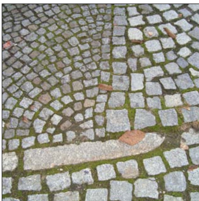
Granitpflaster im öffentlichen Straßenraum in Form von Mosaik- und Kleinpflaster sowie als Bord
