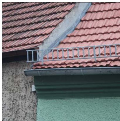
Königstraße 49 und 48: vermörtelte Ortgangkante und Traufgesims in historisch überlieferter Art
