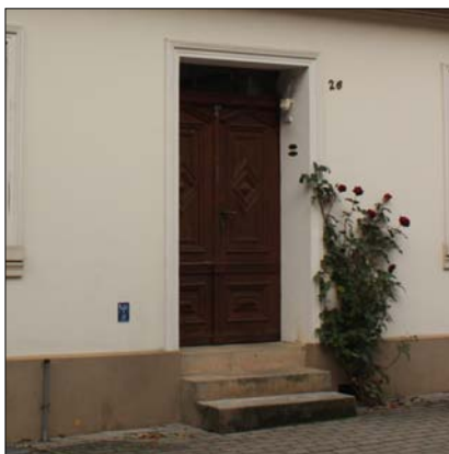
Neue Promenade 26: Zwei Stufen vor dem Haus überwinden den Höhenunterschied zur Tür.
