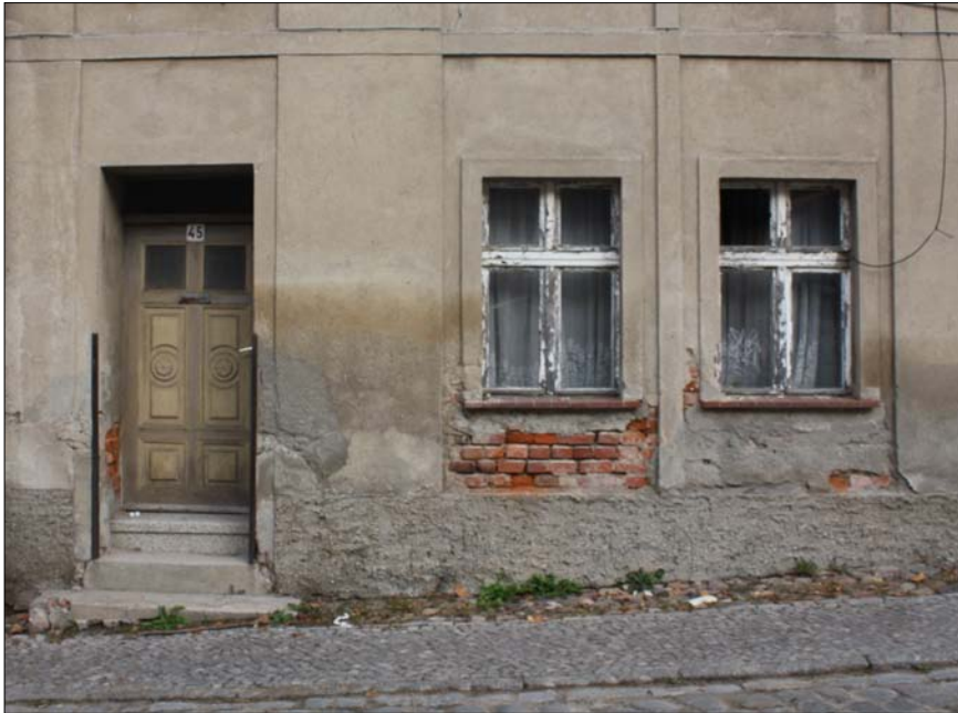
Königstraße 45: Haustür und Fenster eines noch unsanierten Gebäudes zeigen die Ortstypik: Gegliederte, farbig gefasste Holztür; Kämpfer und Pfosten bilden das Fensterkreuz.
