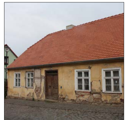
Das Dach der Königstraße 47 ist neu eingedeckt. Das Gebäude wartet auf eine weitere Sanierung.
