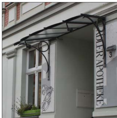
Hauptstr. 3: hier bildet das Vordach aus der Entstehungszeit eine Einheit mit dem Gebäude
