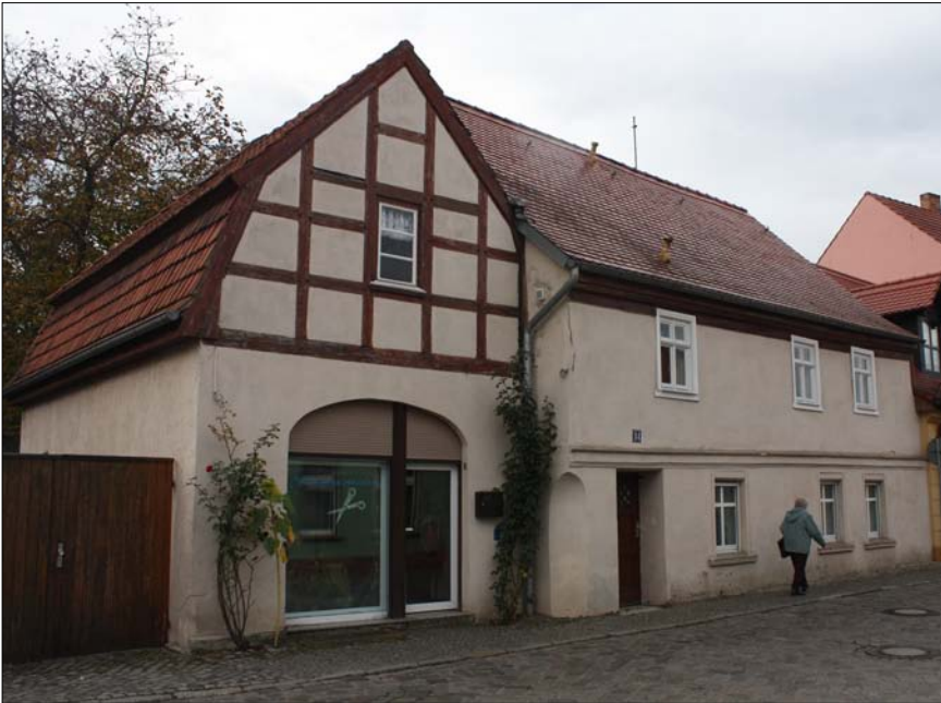
Königstraße 14: zweigeschossiges (Acker-) Bürgerhaus, geduckte Wirkung durch geringe Geschoss- und Traufhöhe, Erdgeschoss massiv, Obergeschoss verputztes Fachwerk, linker Gebäudeteil später ergänzt
